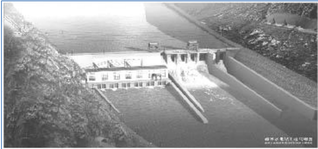
510 MW Zangmu Dam (Wikipedia)
